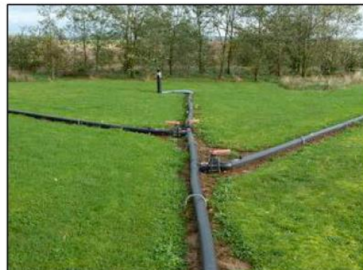
Photo 1 : Illustrations - Puit de captage de biogaz (à gauche), Réseau de captage sur site réaménagé (à droite) (Photo Séché Eco-services)
