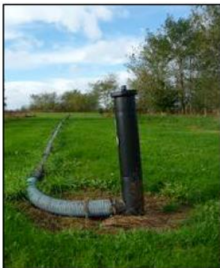
Photo 1 : Illustrations - Puit de captage de biogaz (à gauche), Réseau de captage sur site réaménagé (à droite) (Photo Séché Eco-services)
